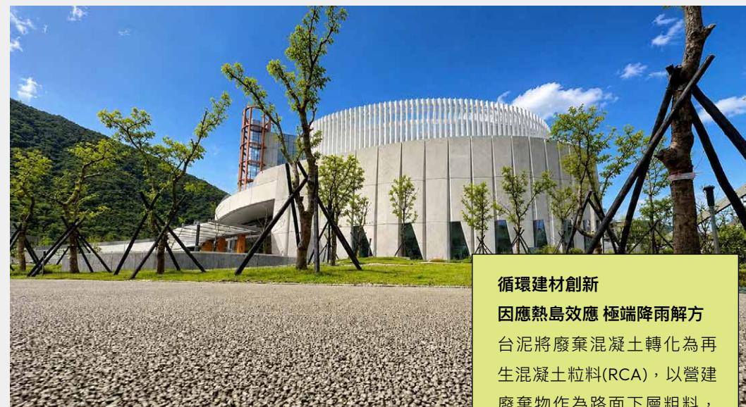
和平廠RRRC透水混凝土鋪面
